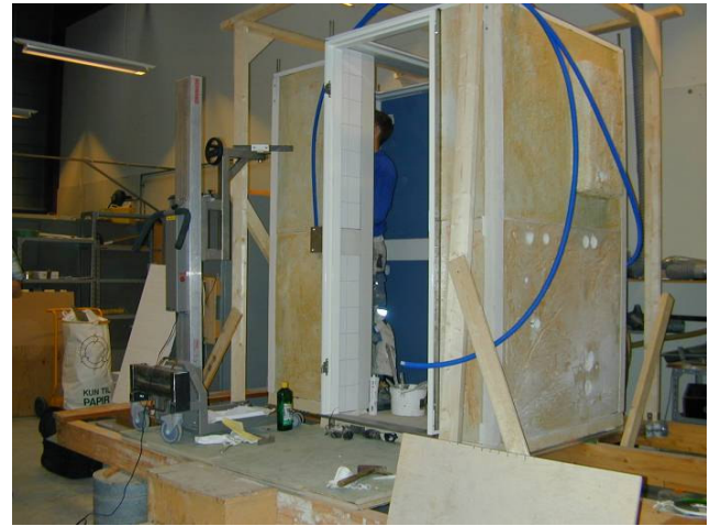
14. Vægmontage er færdig og dørkarm monteret.
