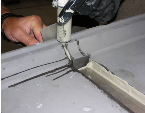
25. Udfugning af hulkehl med specialkæber.
