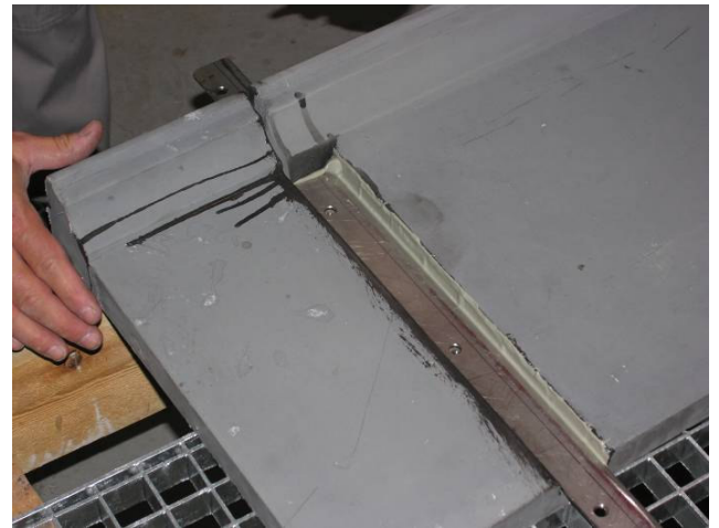
24. Ny gulvsamling med stålskinne monteret.
