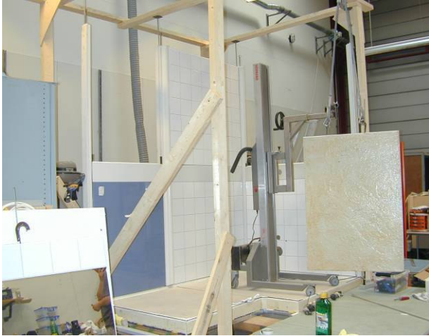
11. Montering af vægelement med løftegrej.
