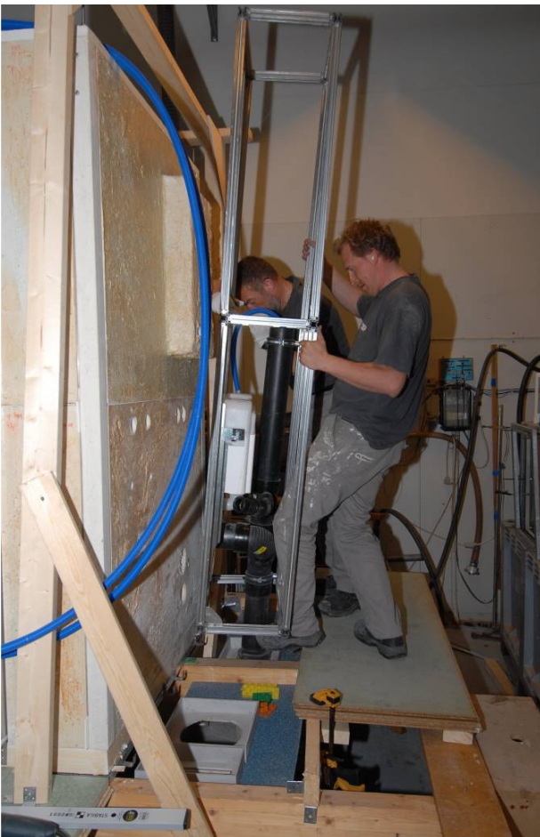
19. Montering af installationsunit
