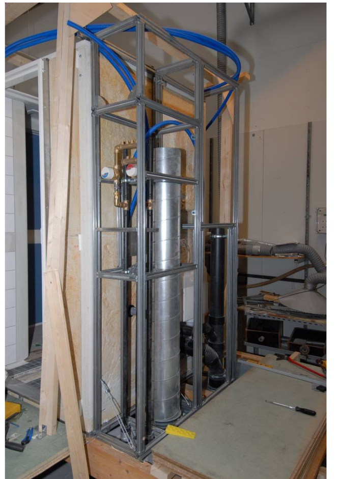
20. Installationer færdiganbragt på kabinen.
