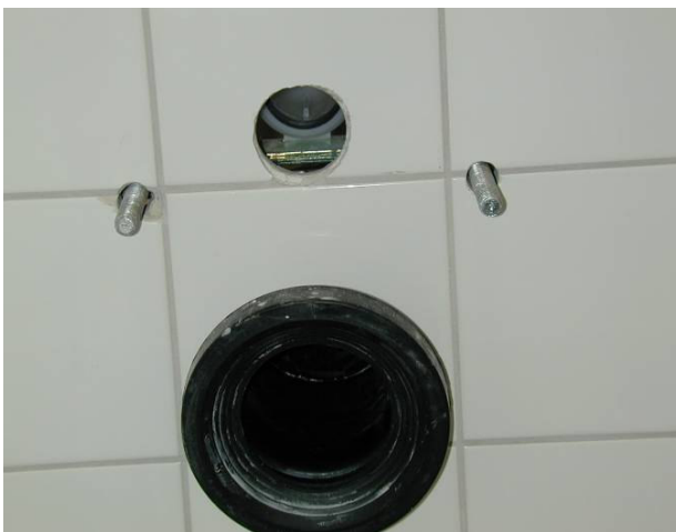
15. Bolte for montering af wc samt monteringshuller for vand og afløb.
