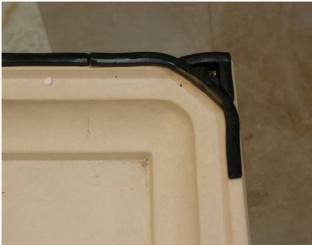
27. Butylbånd på gulvelementets fer for vandtætning mellem gulv- og vægelementer
