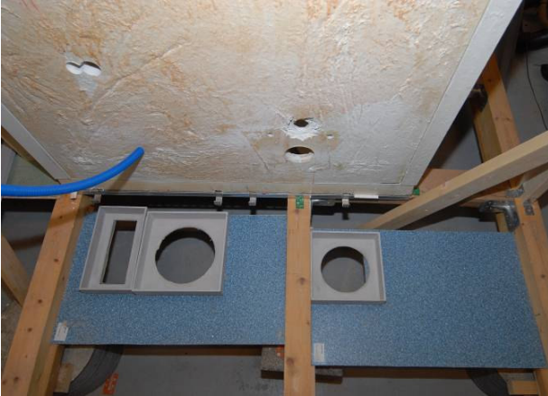
17. Plader (blå) anvendte til at simulere indskudsbrædder. Herpå er udlagt fiberbeton bakker med huller for gennemføringer af afløb, ventilation mv..
