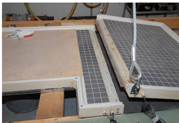
6. Montering af gulvelement nr. 2.
