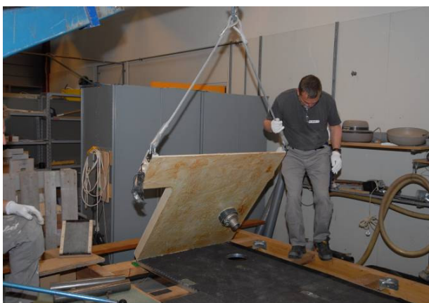
5. Montering af gulvelement med løftegrej (her kran)
