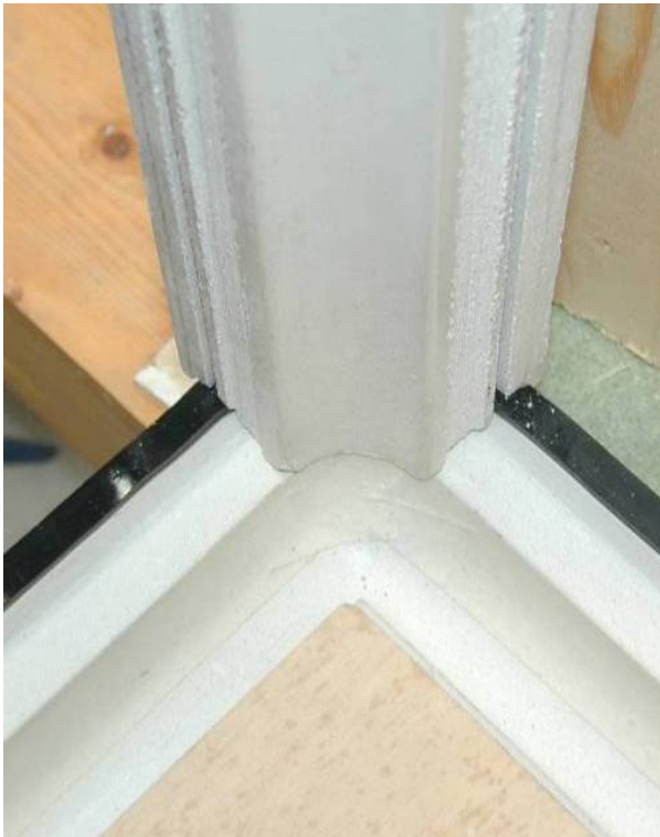
9. Hjørnestolpe monteret med butylbånd mellem bund og stolpe.
