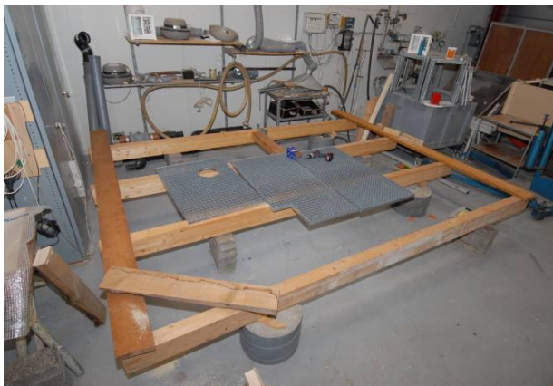
1. Opbygning af bjælkelag.
