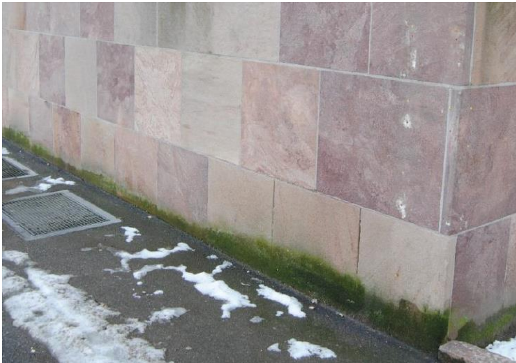
Foto 13. Algevækst på sandstenssokkel, Øster Alle, Østerbro
