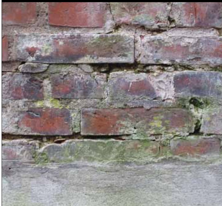
Saltskadedt murværk.
