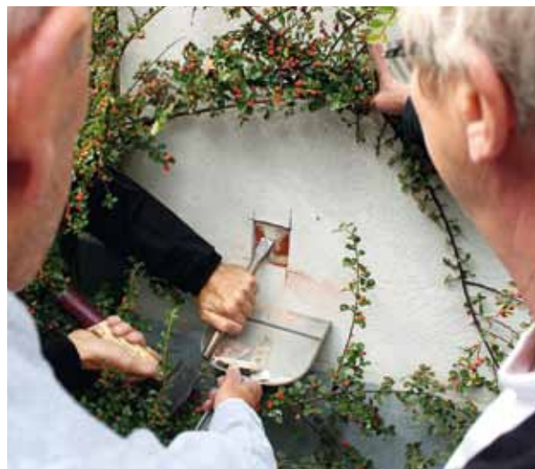
Ejeren holder vejret, mens prøven tages ud. Der mures til lige bag efter.
