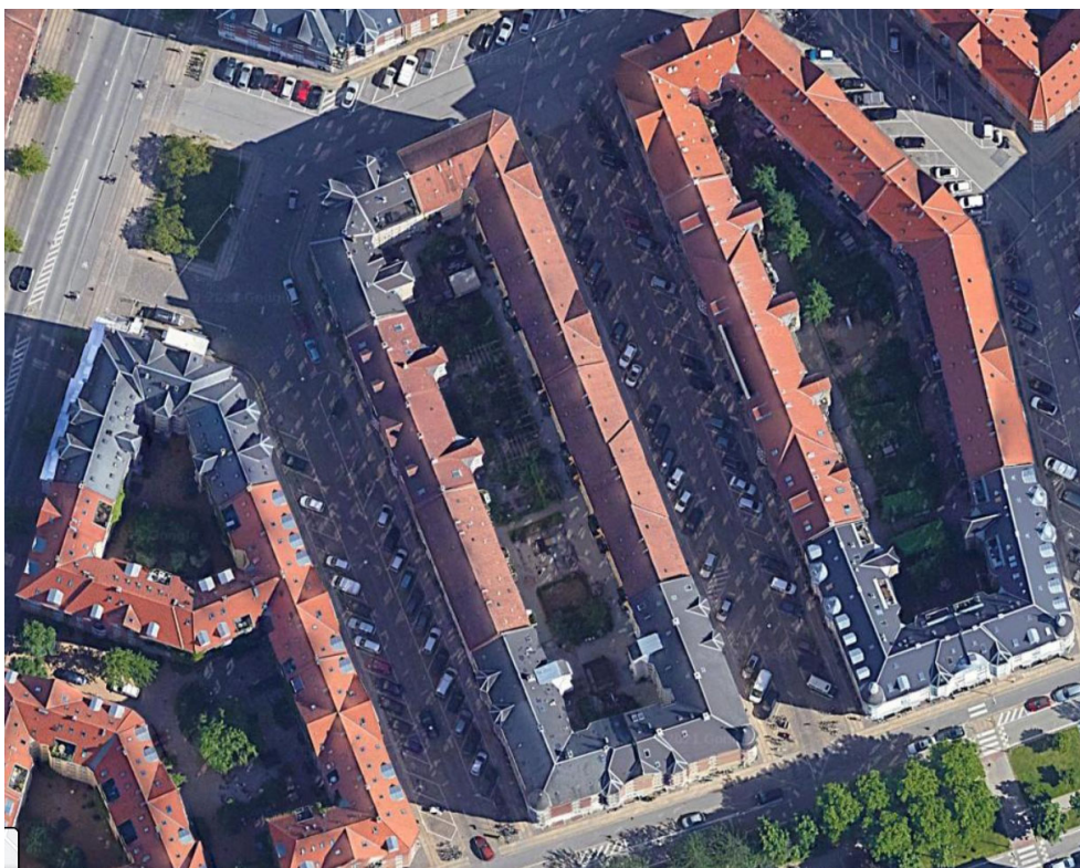
FIGUR 10. Luffoto af ejendommen hvor karreen ses i midten af billedet – Google Maps.
