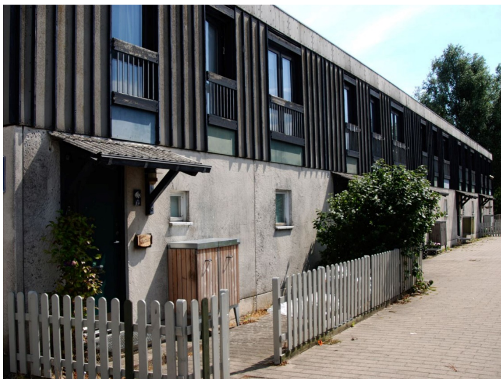
FIGUR 2. Rækkehusene før renovering. Kilde: BO-VEST.
