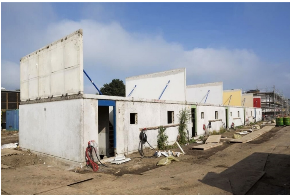
FIGUR 5. Den udførte renovering var meget omfattende.
