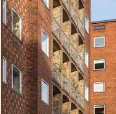
Dronningegården, København, arkitekt Kay Fisker, C.F. Møller og Svenn Eske Kristensen. Et eksempel på murværkets fladevirkninger, mønstermurværk i to farver sten og fremhævning af enkelte detaljer med bl.a. murede stik over åbninger i muren.
