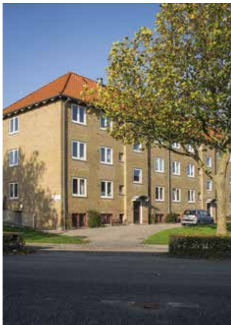
Fortuna, Lyngby, arkitekt Dominia A/S Saddeltaget var enten beklædt med mursten med en hældning på 40-45 grader, ofte med udhæng, eller eternitskifer ved lavere hældninger.
