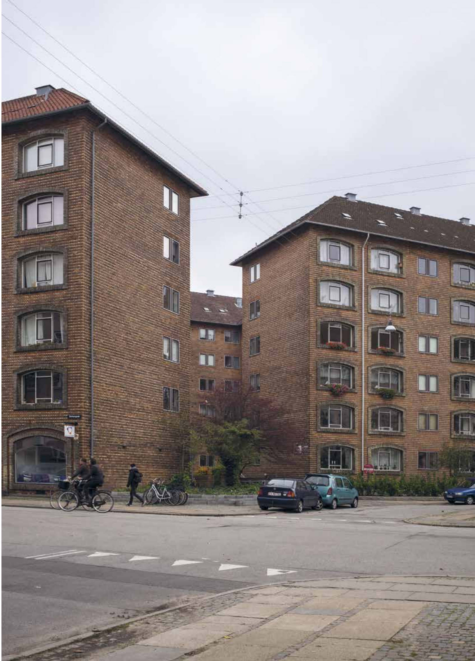
Stefansgårdens høje, slanke bygningsvolumener danner en ryg ud mod de omsluttende gader på Nørrebro. De rundbuede vinduer har fremtrukne murede indfatninger.
