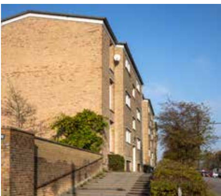
Tingbjerg I. Arkitekt: Steen Eiler Rasmussen.
