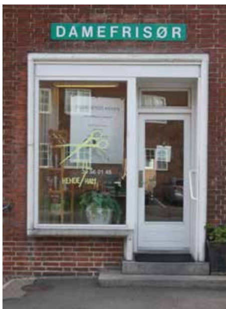
Støbte elementer i kombination med blank mur. Håndværkerhaven i København NV
