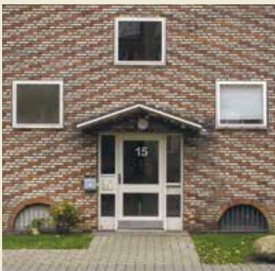
Fogedgården, København, arkitekt Kay Fisker og C.F. Møller. Et eksempel på et indgangsparti med store glasflader i dørpartiet og en lille overdækning, der underordner sig det mønstrede murværks overordnede markering af indgangen.
