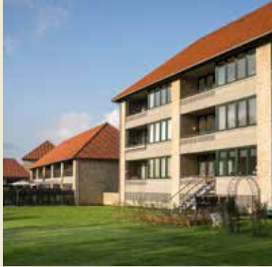
Nærumvænge, Nærum, arkitekt Palle Suenson. Et eksempel på de dominerende valmtage i rød tegl, der afslutter bygningen med et markant og roligt element, der også bliver en vigtig del af bebyggelsens profil i landskabet.
