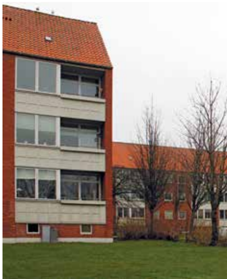
Vinduer og altanfronter er skiftet. Ellers står huset originalt og er i god stand. Klosterparken, Kalundborg.
