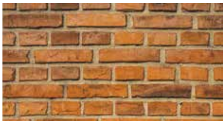
Mursten binder periodens bygninger sammen til en helhed, men de forskellige bebyggelser får et individuelt præg gennem bevidst brug af forskellige sten- og mørteltyper.
