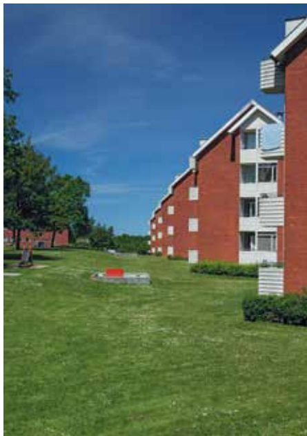
Højstrupparken, Odense, arkitekt Erik Eriksen. Sammenhængen mellem C. Th. Sørensens landskabelige bearbejdning og de velproportionerede bygninger er et godt eksempel på tidens arkitekturidealer.
