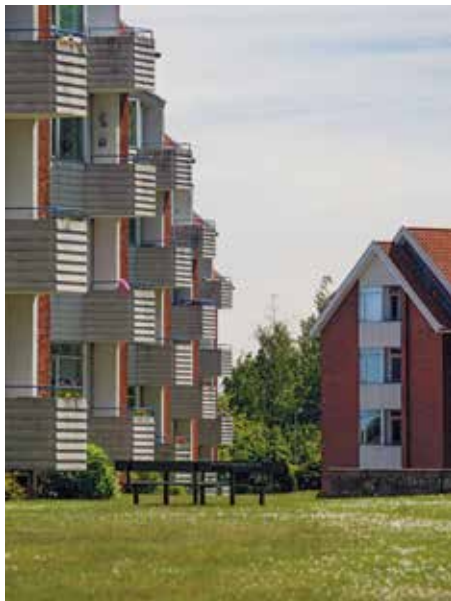
Karnap-/altanelementer i Højstrupparken, Odense
