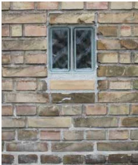
Udsnit af murværk, Kantorparken, København NV
