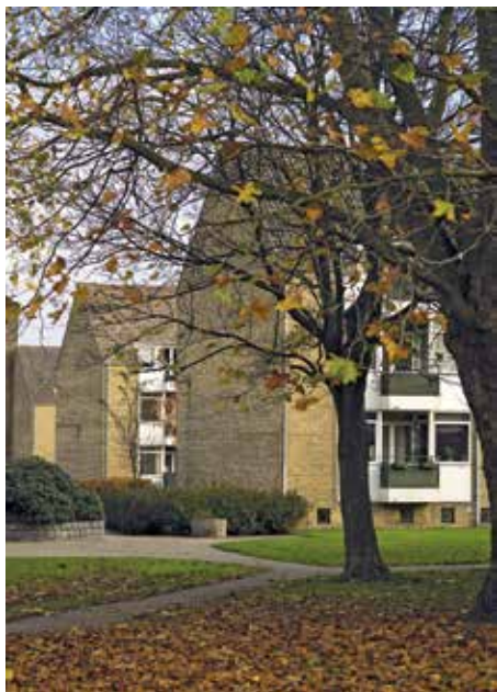
Schweizervænget, Rødovre, arkitekt Dominia A/S. Bygningskroppene i perioden tager udgangspunkt i det enkle, murede hus med saddeltag, der får tilført rytme og kontrast med altankarnappen.
