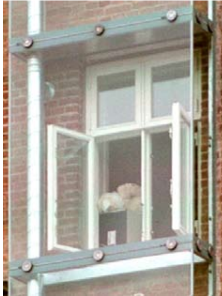
Ud mod en befærdet gade er der opsat en ventileret glaskarnap, der forsynes med frisk luft fra ejendommens gårdside. På den måde er det muligt at åbne vinduerne uden voldsomme gener fra støj og trafik. Arkitekt: Anna Højlund Rasmussens Tegnestue
