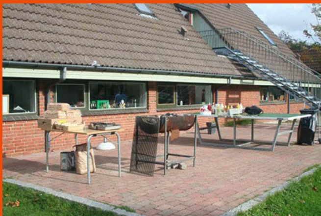
Før: Fritidshuset Poplen før renoveringen.
