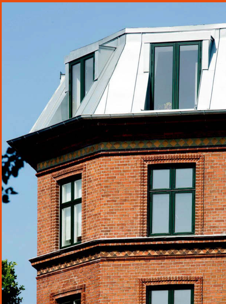
Efter: Etableringen af penthusejligheder på tagetagen var en del af den omfattende renovering af Rymsgade 30, der med sin rensede facade fremstår som et flot eksempel på 1800-tallets murede byggeri.
