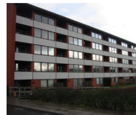
Eksempel på det nyere etageboligbyggeri. Ejendommen er opført af præfabrikerede betonelementer. Taget er også udført af betonelementer med udvendig tagisolering.
