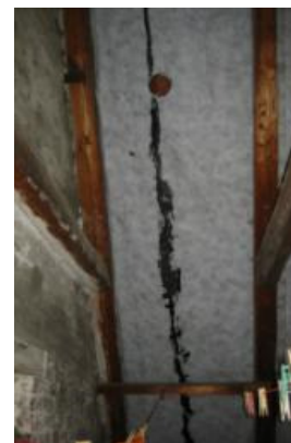
Ovenstående billede viser et eksempel på, at man ved udskiftning af bygningens oprindelige tagdækning har skiftet til en tagdækning med et undertag af banevare.
