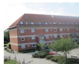
Eksempel på en nyere etageejendomme. Ejendommen er opført med en tagkonstruktion bestående af betonelementer med udvendig tagisolering. Bygningen er opført med en tagkonstruktion af hanebåndsspær. I taget er indrettet taglejligheder, men disse lejligheder har vægge og lofter udført af betonelementer.
