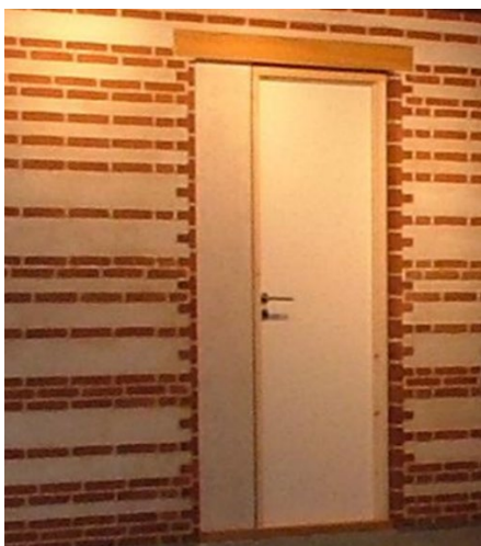
FIGUR 35. Til venstre: Nye røde T-sten blev udviklet som indfatning om døre og vinduer på eksperimenterier på EUC-Nord (Foto: EUC-Nord). Til højre: Eksperimenterierne hos EUC-Sjælland blev bl.a. gennemført på flisecentre i Sydsjælland. (Foto: EUC-Sjælland).
