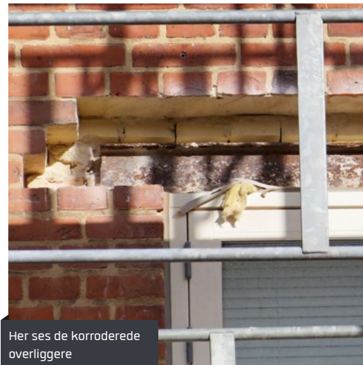
En håndværker opdagede de knapt synlige buler i murværket.
