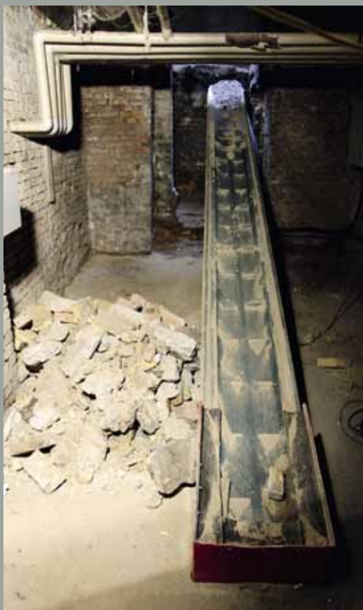
Kælderen er nu udgravet og klar til indsavning af membraner. Beton og jord transporteres blandt andet op med en transporter, som det ses på billedet.
