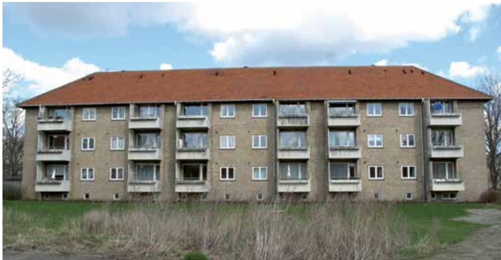
Fortunbyen før renovering
