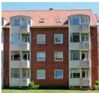
Altankarnap som påsat element i Højstrupparken, Odense.
