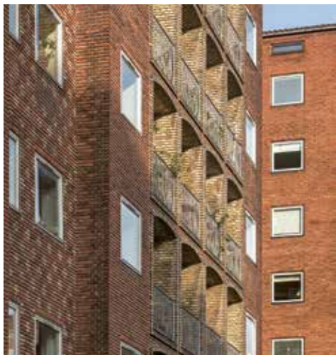
Dronningegården, København, arkitekterne Kay Fisker, C.F. Møller og Svønn Eske Kristensen. Et eksempel på murværkets fladevirkninger, mønstermurværk i to farver sten og fremhævelse af enkelte detaljer med blandt andet murede stik over åbninger i muren.
