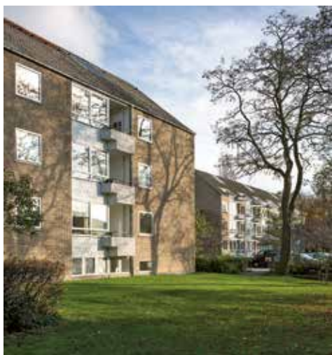
Bredalsparken, Hvidovre, arkitekt Svønn Eske Kristensen. Et eksempel på en delvist indeliggende altan, der griber fat i karnappen med det reliefudsmykkede betonværn og danner et samlet element i kontrast til murværket.
