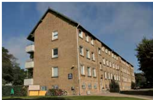
Gavl/facade (kilde: Københavns Museum).
