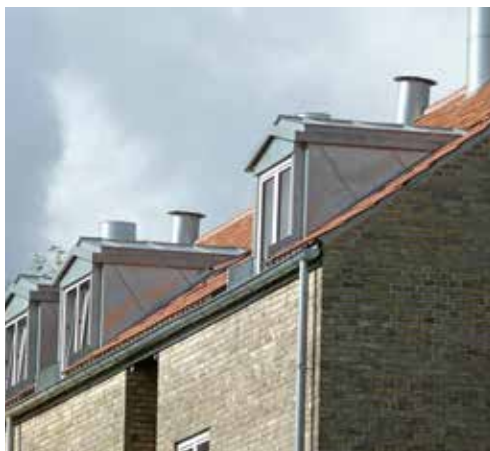
Udskiftning af tag samt efterisolering er lykkedes, uden at tagprofilen er ændret.
