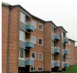
Altankarnap, der er drejet for at opnå optimale lysforhold, i bebyggelsen på Uffesvej, Viby.
