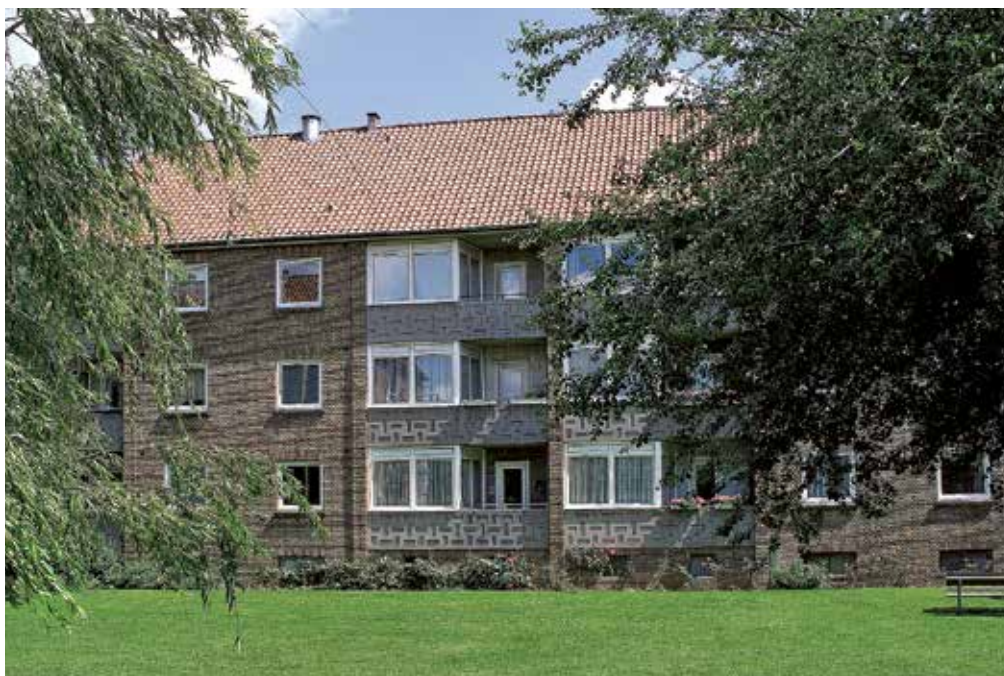
Brystninger ved altaner understreger bygningens vertikale liner. De er udført i beton - her med en mild ornamentering. Spurvegården, Hvidovre, fra 1952, Lejerbo.
