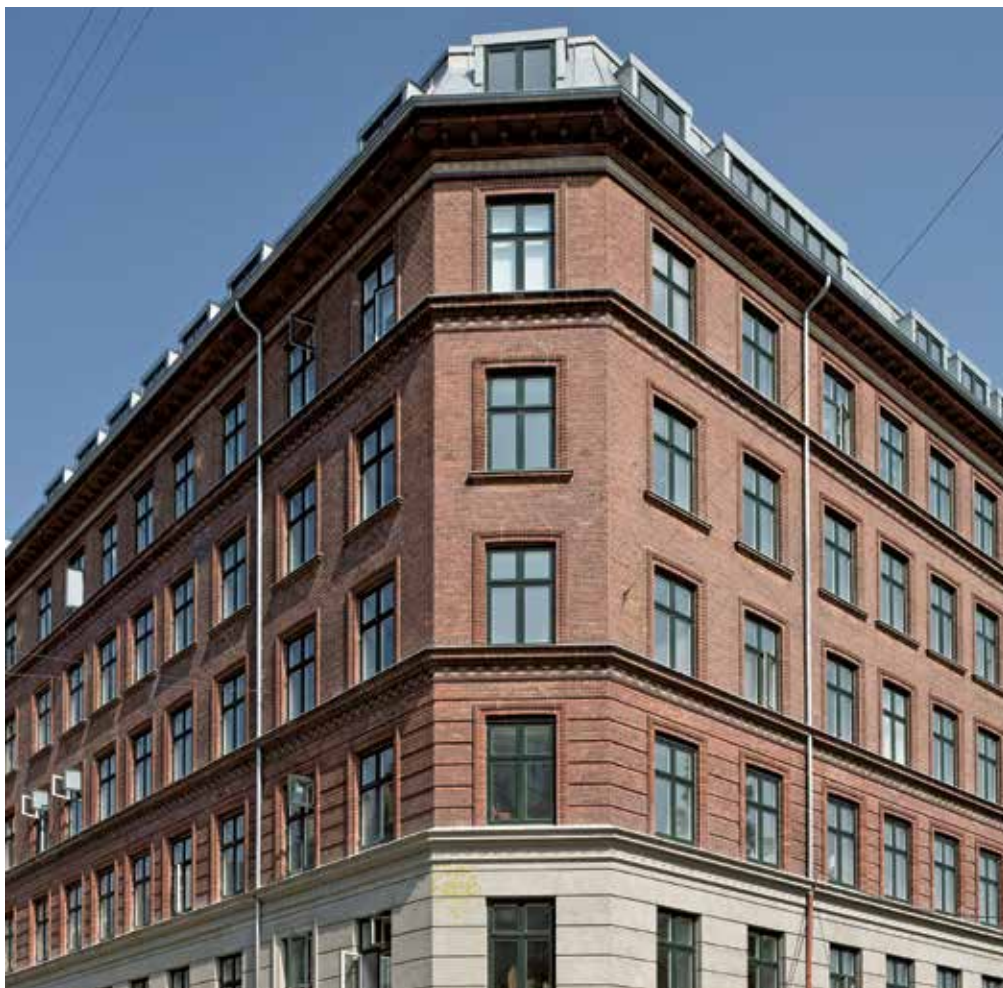
Indvendig efterisolering, billede fra Ryesgade 30. Ejendommens facade fra 1896 fremstår uændret efter energirenoveringen, og de nye vinduer er holdt i samme dimensioner som de originale.
