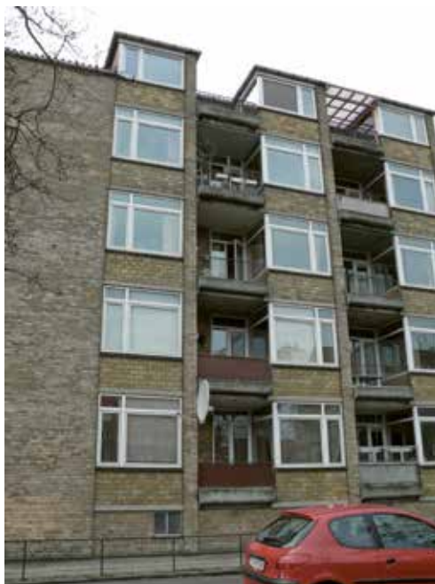
Bispeparken før renoveringen.
