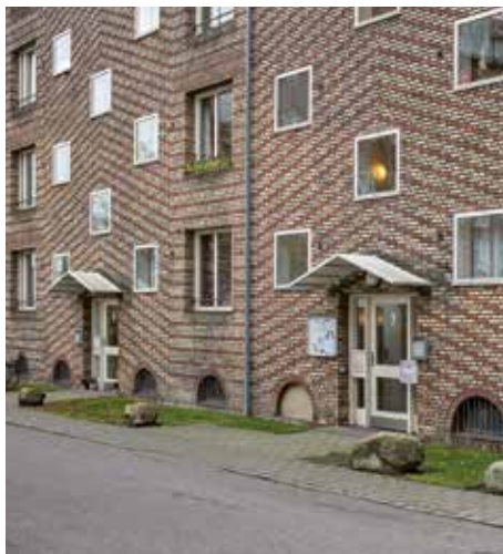
Fogedgården, København, arkitekter Kay Fisker og C.F. Møller. Et eksempel på et indgangsparti med store glasflader i dørpartiet og en lille overdækning, der underordner sig det mønstrede murværks overordnede markering af indgangen.
