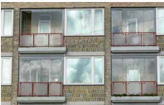
Altanerne har fået en støjreducerende glasinddækning mod larm fra de omkringliggende hovedveje.
