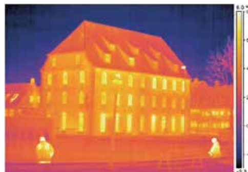
Figur 1. Termografi af bygning med angivelse af kuldebroer
