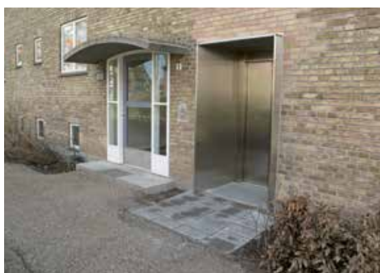
For at skabe bedre tilgængelighed og ældreegnede boliger ses her, hvordan et indgangsparti er ændret med tilføjelse af elevatoradgang til højre for hovedindgangen.
