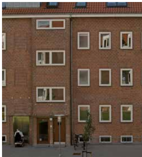
Eksempel på, at elevatoren er placeret inde i bygningen ved siden af trappeforbindelsen. Man har her inddraget noget areal i lejlighederne og derved sikret, at der er adgang til alle lejligheder for alle. Elevatorens vertikale motiv er markeret i facaden og understreger derved facadens eksisterende rytme. Eksemplet er fra Sprotoften i Nyborg, opført i 1952.
