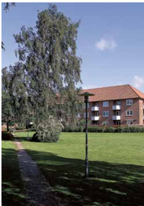
Recesser, nicher og detaljering af murværket giver arkitekturen en særlig stoflighed. Spurvegården i Hvidovre fra 1952, Lejerbo.
