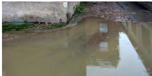
Tjek af kælder og afløb i regnvejr. Vandet ledes væk fra kælderen som planlagt.
