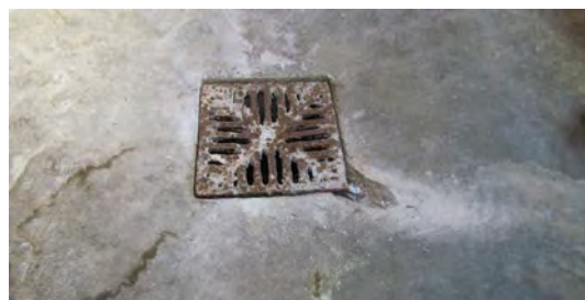
Afløbsrist af metal. Afløbsristen bør skrues fast, da en rotte kan løfte op til 1,5 kg og dermed også risten.
