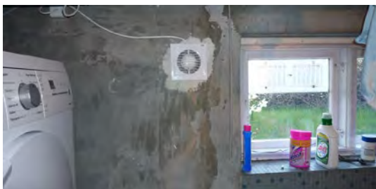
Fugtstyret ventilator monteret i vaskekælder.
